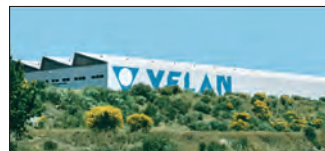
Lisbon, Portugal Velan Válvulas Industriais, Lda.
